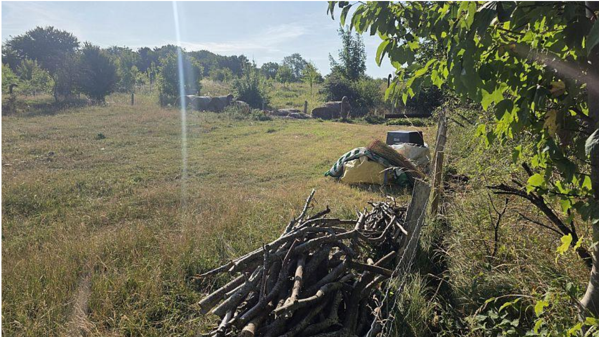
Abbildung 14 Baugebiet, Ablagerungen (Quelle: eigene Aufnahme vom 30.07.2026)
