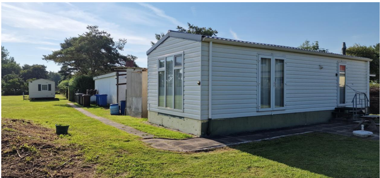
Abbildung 9: Für den Abbruch vorgesehene Gebäude im Norden des Geltungsbereichs.
