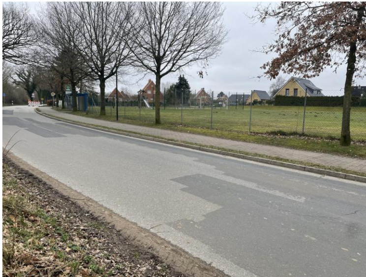
Foto: Kreisstraße 54 mit Blick auf den Sportplatz und eine Baumreihe an der Straße (PLOH)
