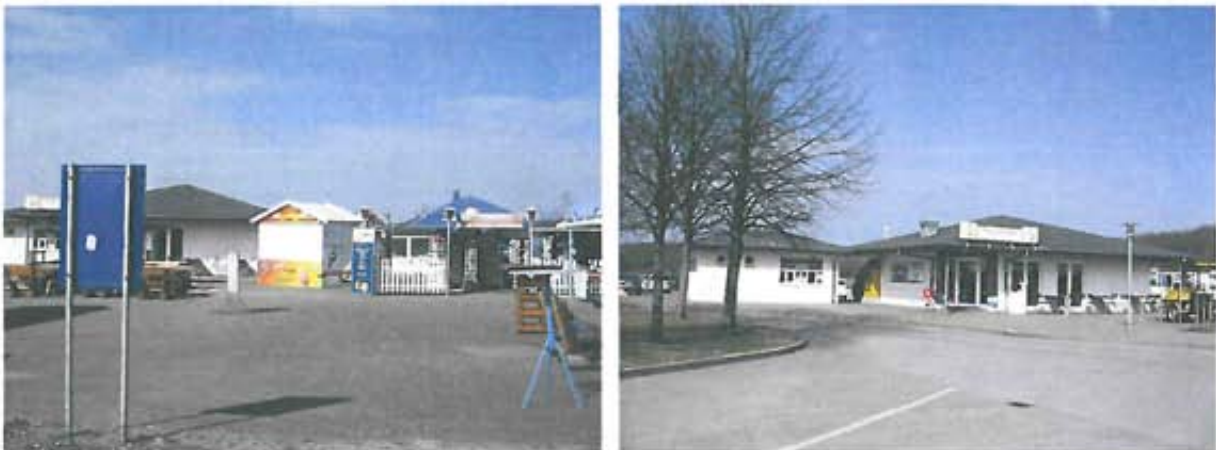
Abbildung 8: gepflasterte Aufstellfläche Bestand (Quelle: blfa, April 2013)
