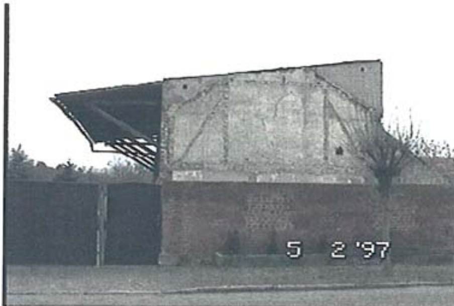
Bild 27 Scheunengiebel mit Hoftor und Backsteinmauer
