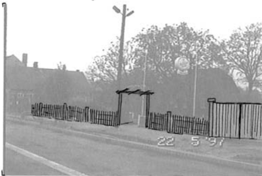
Bild 29 Straßenseitige Ansicht Eingang Gemeindebüro
