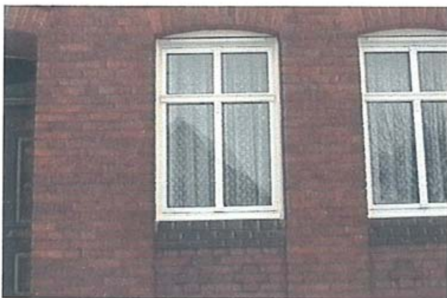
Bild 33 Neues Fenster im Backsteinmauerwerk
