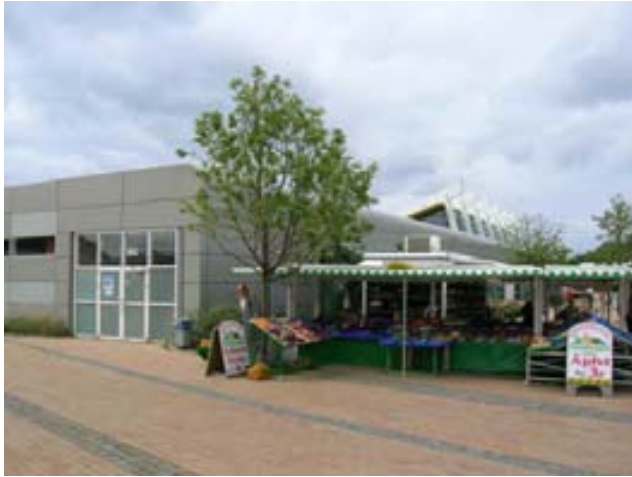
Foto links: Auf der linken Seite ist die graue Fassade des Kurmittelhauses sichtbar. Die Fassade ist sehr glatt gestaltet. Am oberen Rand fehlt eine Dachabschlussleiste.
