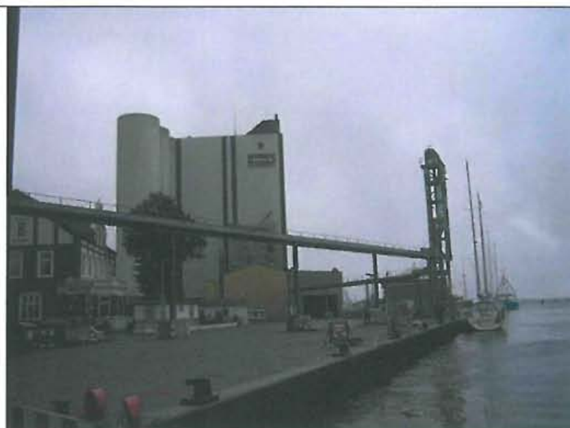
Getreide Silo und Transportleitungen der Getreide Ag am Binnenhafen
