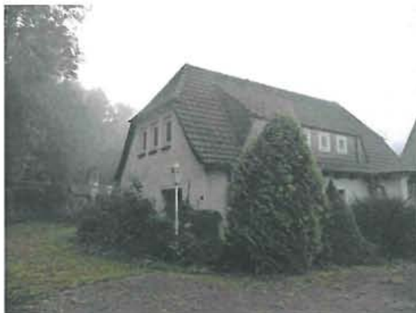
Abb. 23 Die Gebäude des ehem. Hotels stehen in Nähe zu den Bäumen am Hang des Schwentinetals - ein Blick von Norden nach Süden
