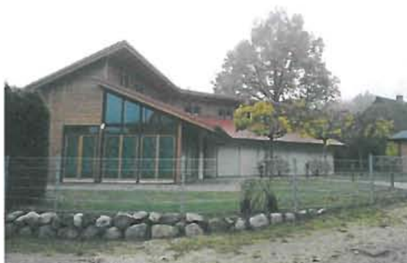
Abb. 25 Blick von Norden auf die Straßenfront des Gebäudes Leonhard-Boldt-Straße Nr. 27
