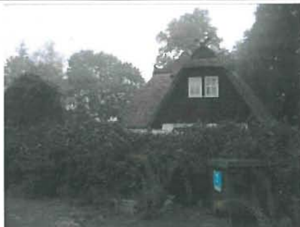
Blick auf die Südseite des Gebäudes Leonhard-Boldt-Str. Nr. 23
