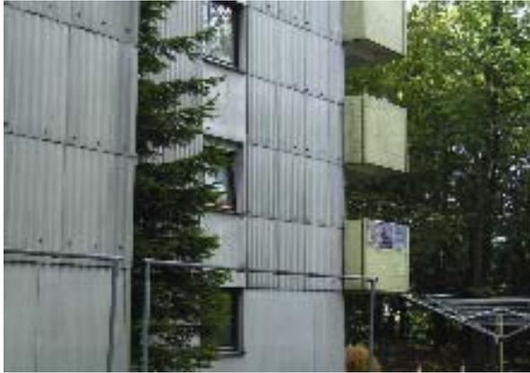
Hochhaus mit teilweise beschädigter Fassadenbekleidung aus Asbestzementtafeln (Andreas-Mayr-Str. 5)
