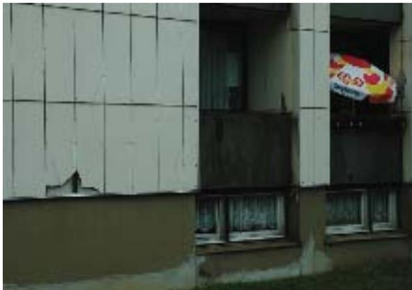
Beschädigte Fassadenbekleidung, Feuchteschäden im Sockelbereich (MFH Buchenstraße 7/8)
