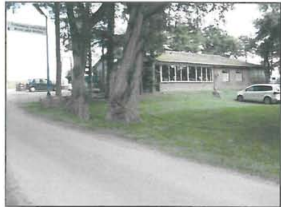
Foto 2: Zufahrt und Gaststätte
