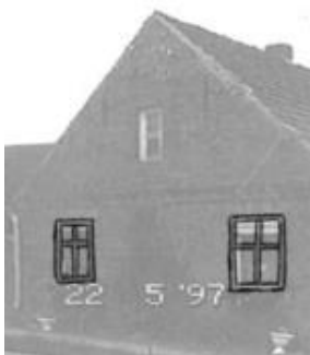
Typische Fensterteilung Langensalzwedel. Quelle: Dorferneuerungsplan
