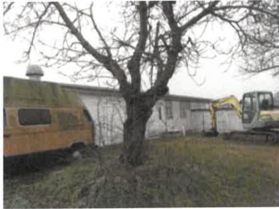
Foto 11: Gebäude 4 mit Baum im Nahbereich
