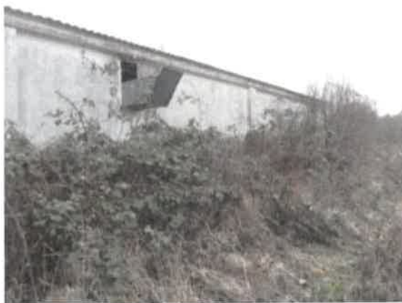
Foto 1: Gebäude 1: Lagerhalle mit Betonverblendung, Eternit-Welldach
