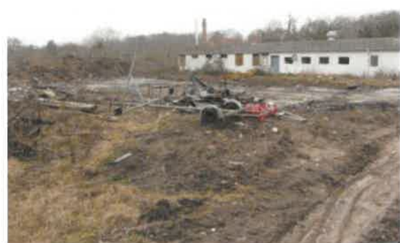
Foto 8: Gebäude 4 im Hintergrund, verblendet wie Gebäude 1-3
