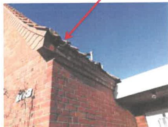
Foto 14: Wohnhaus Sundweg 103 Südostseite, Detail mit Spaltenstrukturen an defekten Dachabschlüssen (Pfeil), (Lage s. Abb. 4: Gebäude 103)
