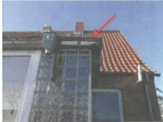
Foto 6: Wohnhaus Sundweg 105, Ostseite, Detail mit Spaltenstrukturen an defekten Dachabschlüssen (Pfeil), (Lage s. Foto 4)
