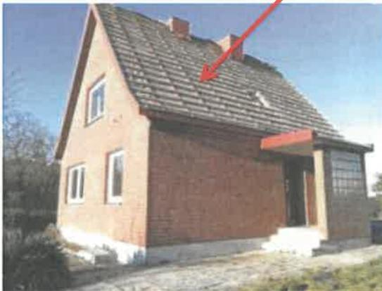
Foto 19: Wohnhaus Sundweg 101 Südostseite, Dachziegel abgedeckt (Pfeil) mit Öffnungen (Lage s. Abb. 4: Gebäude 101)
