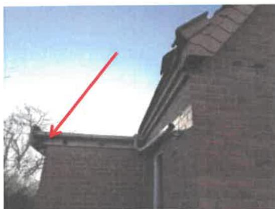
Foto 15: Wohnhaus Sundweg 103 Südostseite, Detail mit Spaltenstrukturen an defekten Dachabschlüssen (Pfeil), (Lage s. Foto 16)
