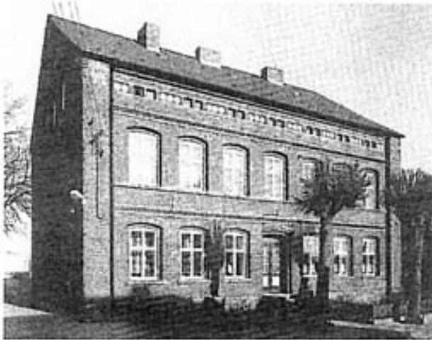
Um 1900 wurde die ehemalige Schule (Haus Nr. 39) errichtet – ein zweigeschossiges, siebenachsiges Traufen-gebäude aus unverputztem Backstein. Die Geschosse sind an den Traufseiten durch Deutsche Bänder getrennt, das Dachgeschoss unter dem flachen Satteldach wurde ausgebaut.
