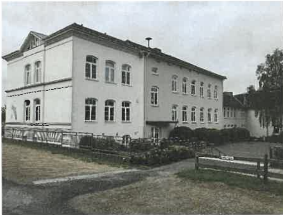
Foto 1: Nordseite Gebäude Nr. 1. Mehrere Vorkästen vorhanden. Blick Richtung Südwest.
