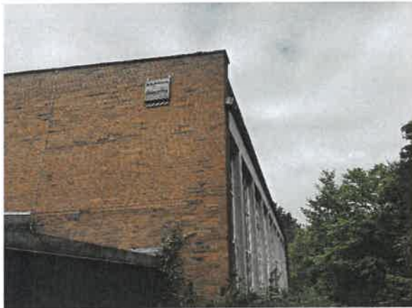
Foto 7: Ostseite Gebäude Nr. 4, Blick Richtung Nordwesten. Fledermauskästen und Brutvogelkästen vorhanden.
