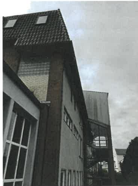
Foto 4: Westseite Gebäude Nr. 3, Blick Richtung Südwesten.
