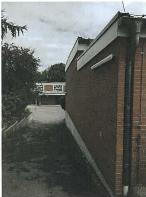
Foto 3: Westseite Gebäude Nr. 2, Blick Richtung Nordosten.
