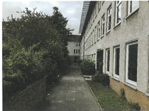
Foto 2: Ostseite Gebäude Nr. 3. Blick Richtung Südwesten.
