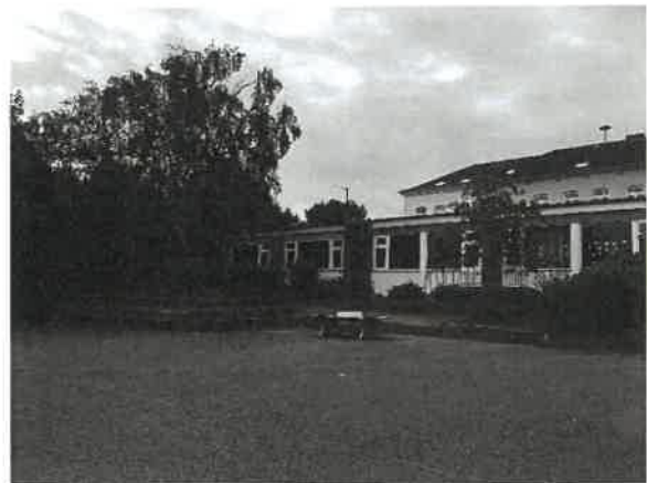
Foto 6: Nordseite Gebäude Nr. 2, Blick Richtung Süden.
