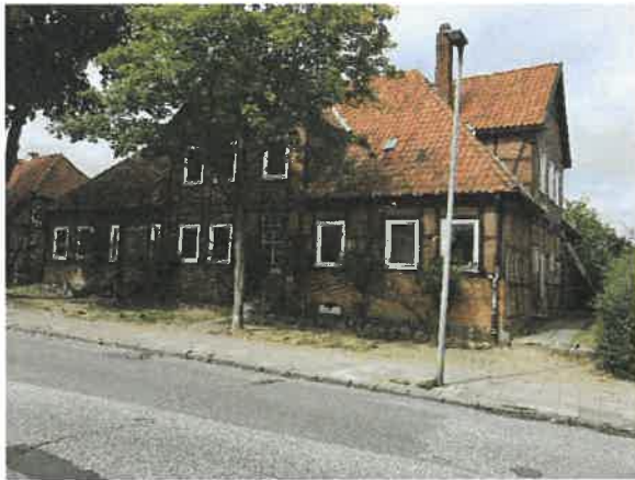
Foto 11: Ostseite Gebäude Nr. 5, Blick Richtung Westen.
