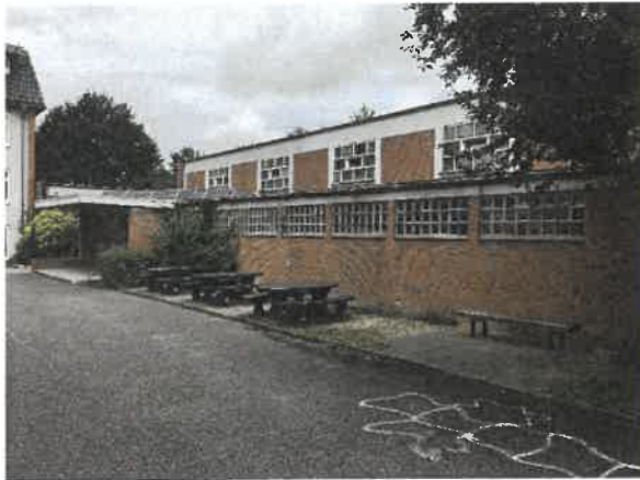
Foto 5: Südseite Gebäude Nr. 4, Blick Richtung Nordwesten.
