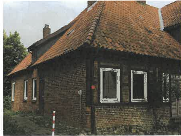
Foto 12: Südseite Gebäude Nr. 5, Blick Richtung Nordwesten.
