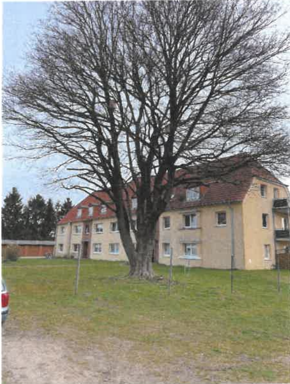
Abb. 8: Zu erhaltender Einzelbaum im Norden mit besetzten Dohlenkästen.
