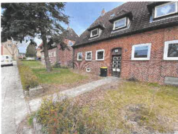
Abb. 4: Vom Abriss betroffene Gebäude Nr. 2 und 3 sowie Verlust von Tanne und Hecken.
