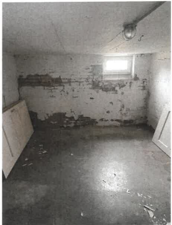
Abb. 11: Kellerabteil, gut einsehbar.
