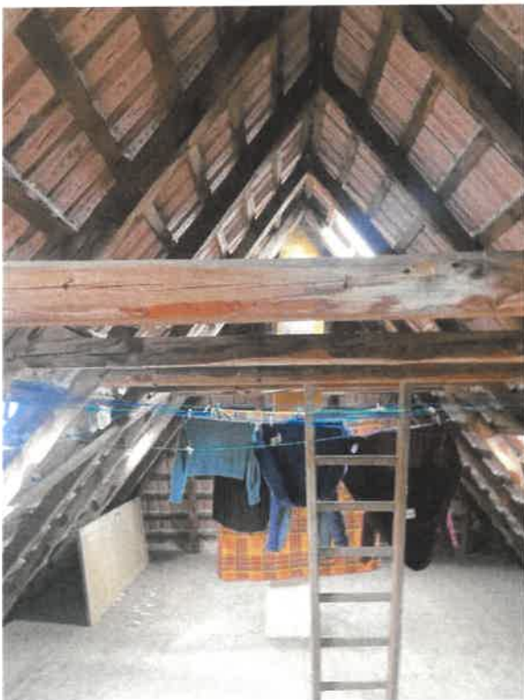
Abb. 10: Dachboden, ohne Isolierung, gut einsehbar.
