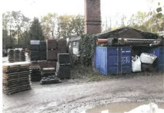
Heizhaus ehem. Gärtnerei und Lagerfläche (Mietfläche)
