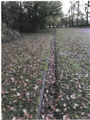
Blick nach Westen Entwässerung nördl. angrenzendes Grundstück
