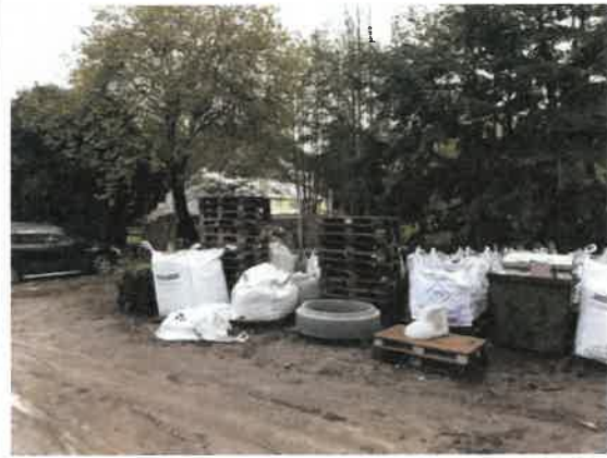
Lagerfläche für Baustoffe (Mietfläche)
