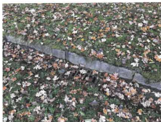
Einläufe der nördl. angrenzenden Parkplatzflächen
