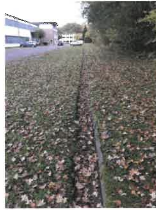
Blick nach Osten Entwässerung nördl. angrenzendes Grundstück
