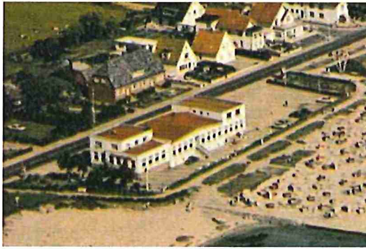
Abb.: Archiv Gemeinde Scharbeutz Strandhalle ca. 1970
