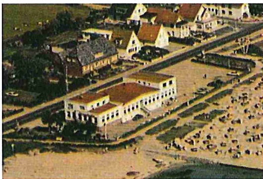
Abb.: Archiv Gemeinde Scharbeutz Strandhalle ca. 1970
