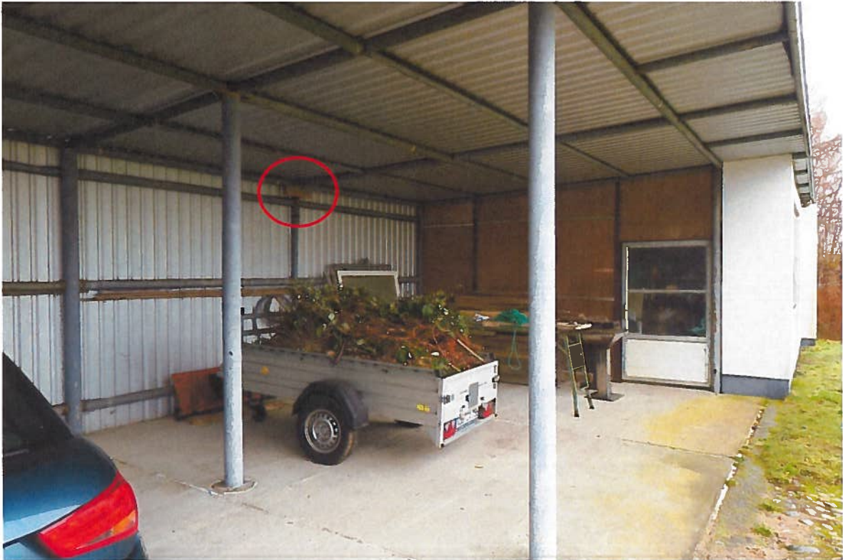
Abbildung 14: Gebäude B1 mit Rauchschnalben-Nisthilfen.
