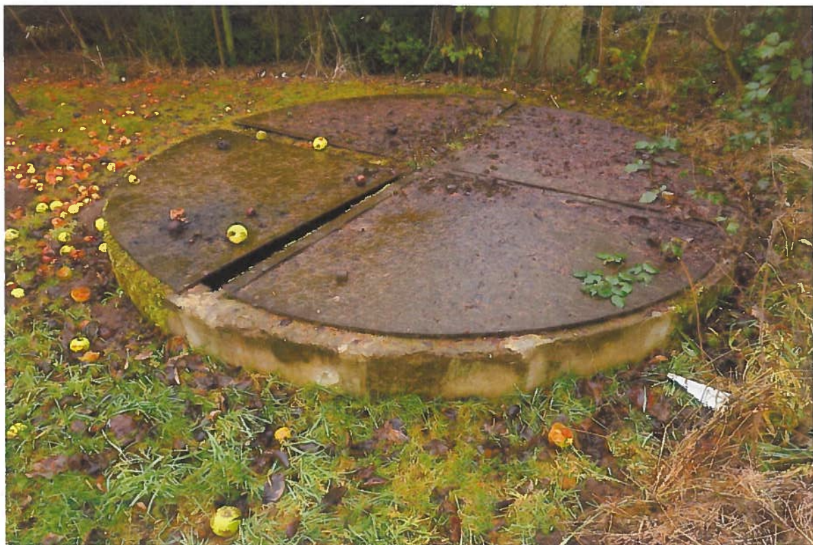
Abbildung 13: Abwassersammelgrube A4.
