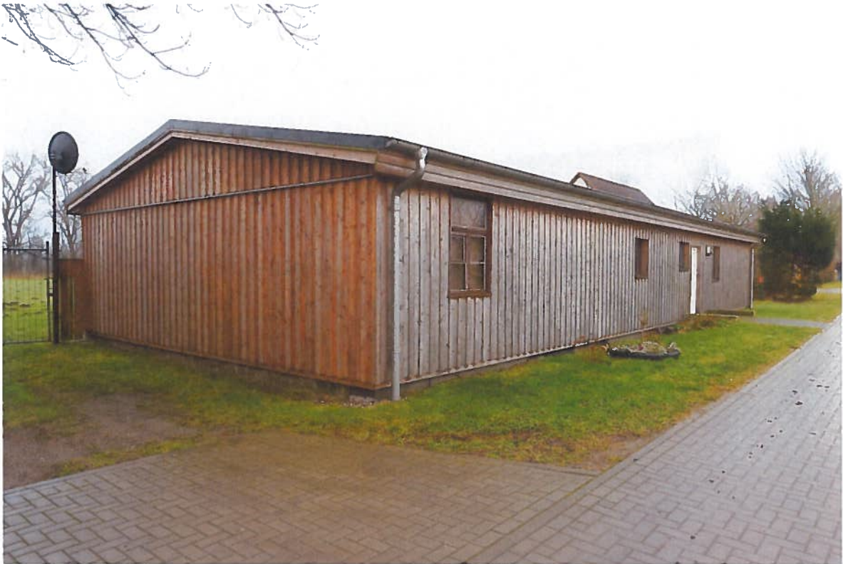
Abbildung 8: Gebäude A1 im Norden des Plangebiets.
