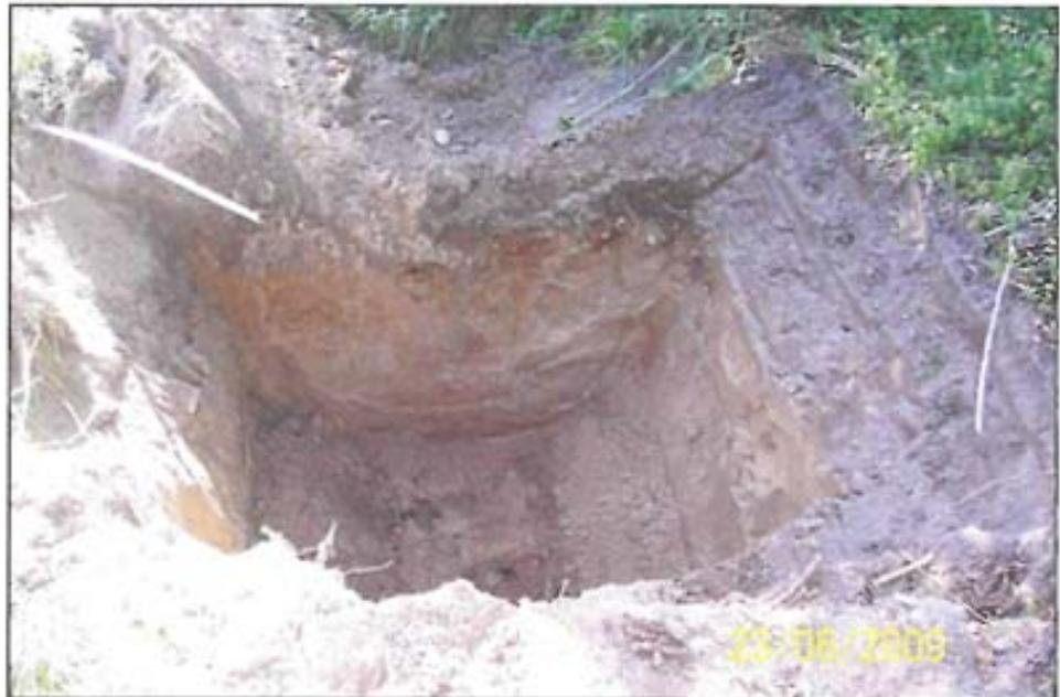
**Abb. 05:** Schürfgrabung S 01: Hier standen unter einer Mutterbodenauflage Sande bis zur Endteufe von 2,0 m an.
