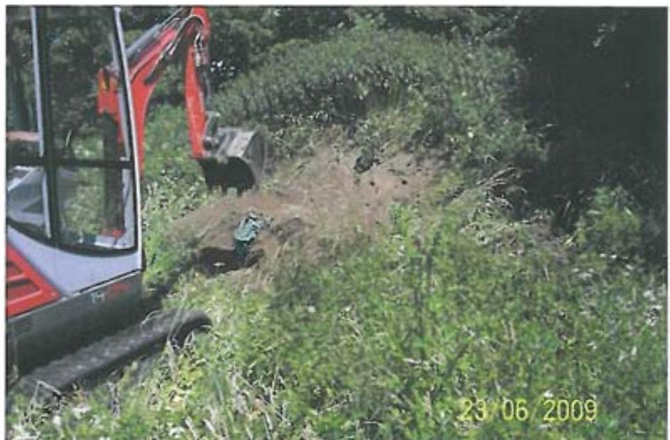
**Abb. 06:** Schürfgrabung S 07: In einem Haufwerk im Norden der Untersuchungsfläche wurden Hausmüll-typische Ablagerungen festgestellt.
